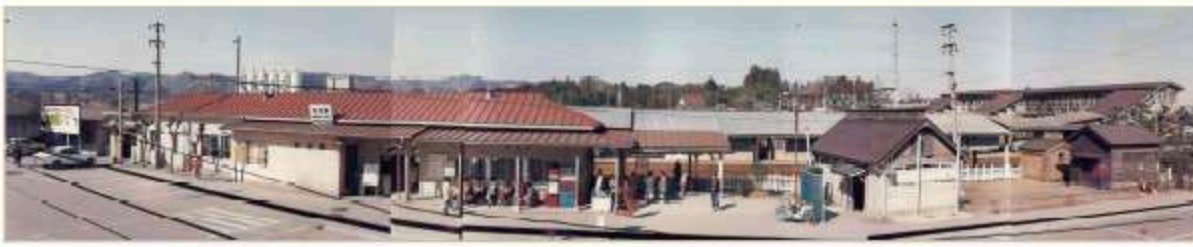
解体直前の一代前の岩沼駅。昭和53年頃に撮影か。（大内写真館所蔵）
